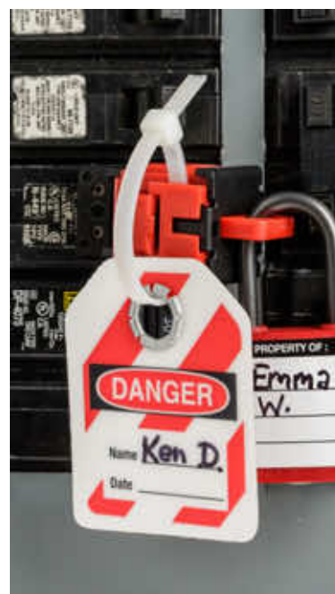
Puede asegurarse con bridas plásticas y/o cándados de seguridad
